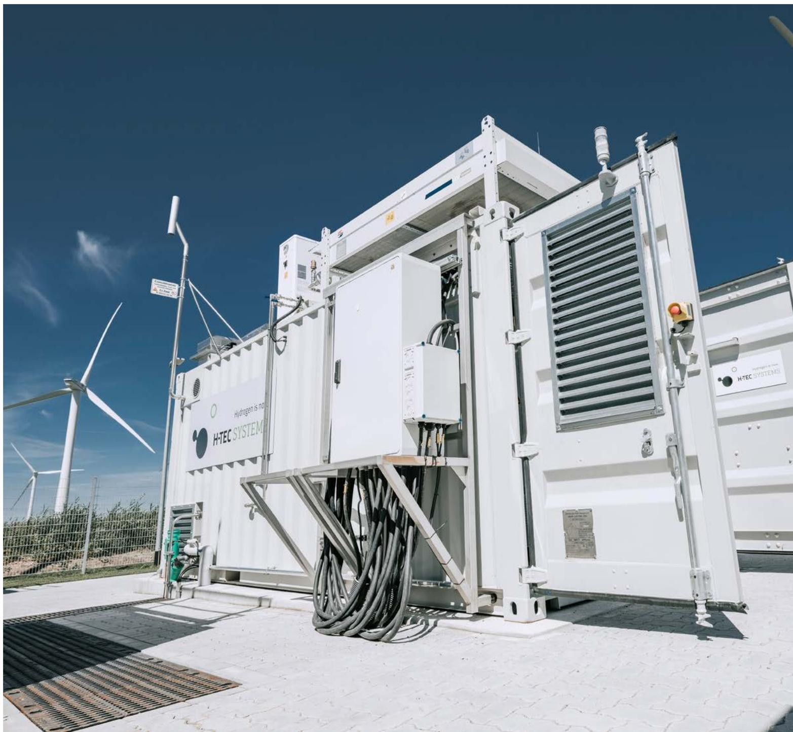
Die bei der Elektrolyse entstehende Abwärme wird zum Beheizen von Gebäuden genutzt. Somit erreicht die Elektrolyse einen Wirkungsgrad von mehr als 95 Prozent. Foto: GP Joule
