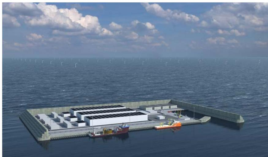
Auf einer künstlichen Insel in der Nordsee will Dänemark Strom aus Offshore-Windkraftanlagen bündeln. Auch ein Kraftwerk zur Umwandlung und Speicherung in Wasserstoff ist dort geplant.
