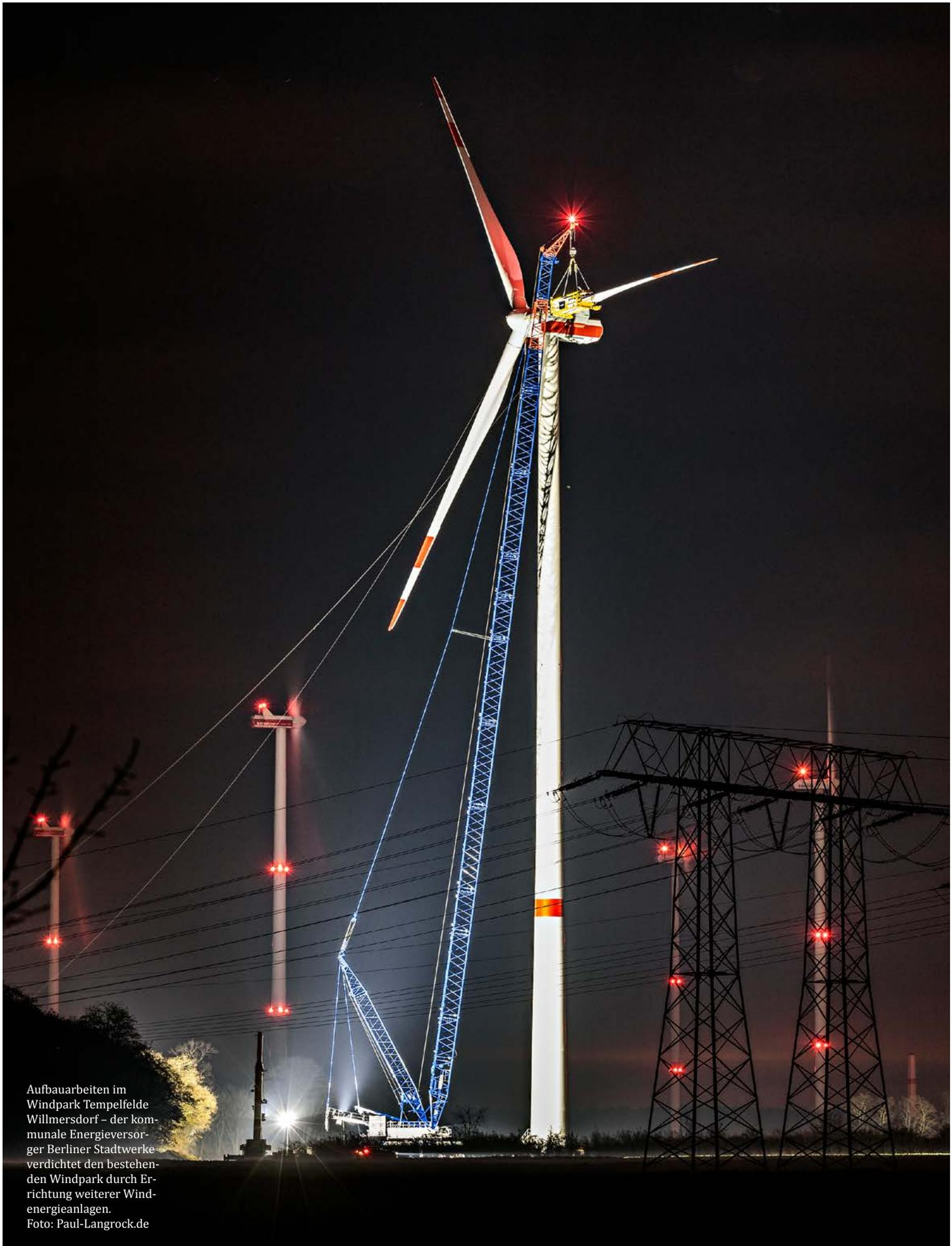
Aufbauarbeiten im Windpark Tempelfelde Willmersdorf – der kommunale Energieversorger Berliner Stadtwerke verdichtet den bestehenden Windpark durch Errichtung weiterer Windenergieanlagen.
