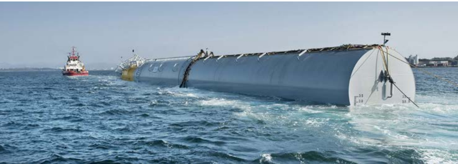
Spar Buoy: Der Turm setzt sich unter Wasser mit einem langen Rohr fort, das mit Ballast gefüllt ist. Foto: Kim Laland/Digitalt
