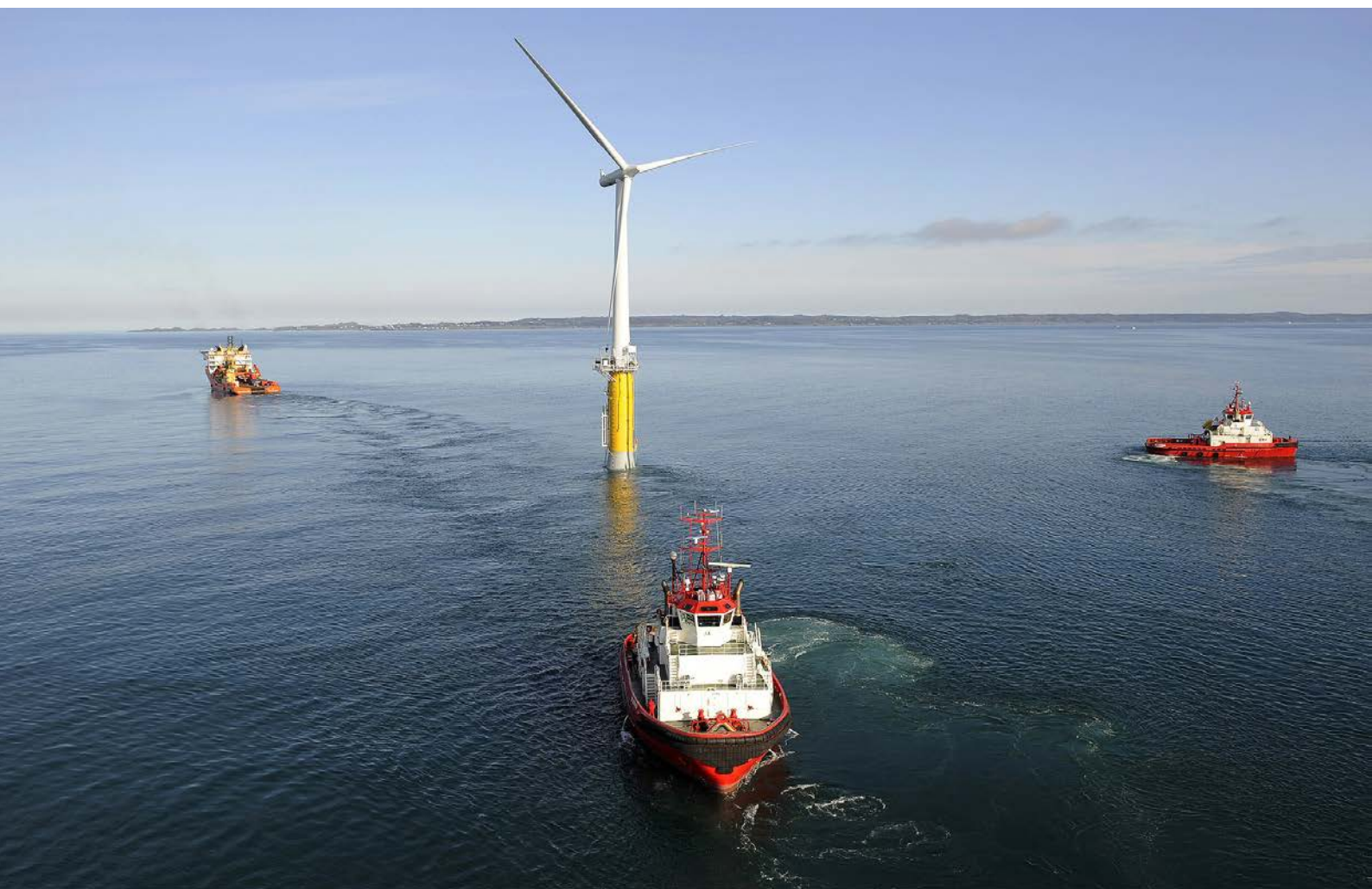
Die weltweit erste schwimmende Windenergieanlage wird in Norwegen in einer Wassertiefe von 220 Metern errichtet. Foto: StatoilHydro
