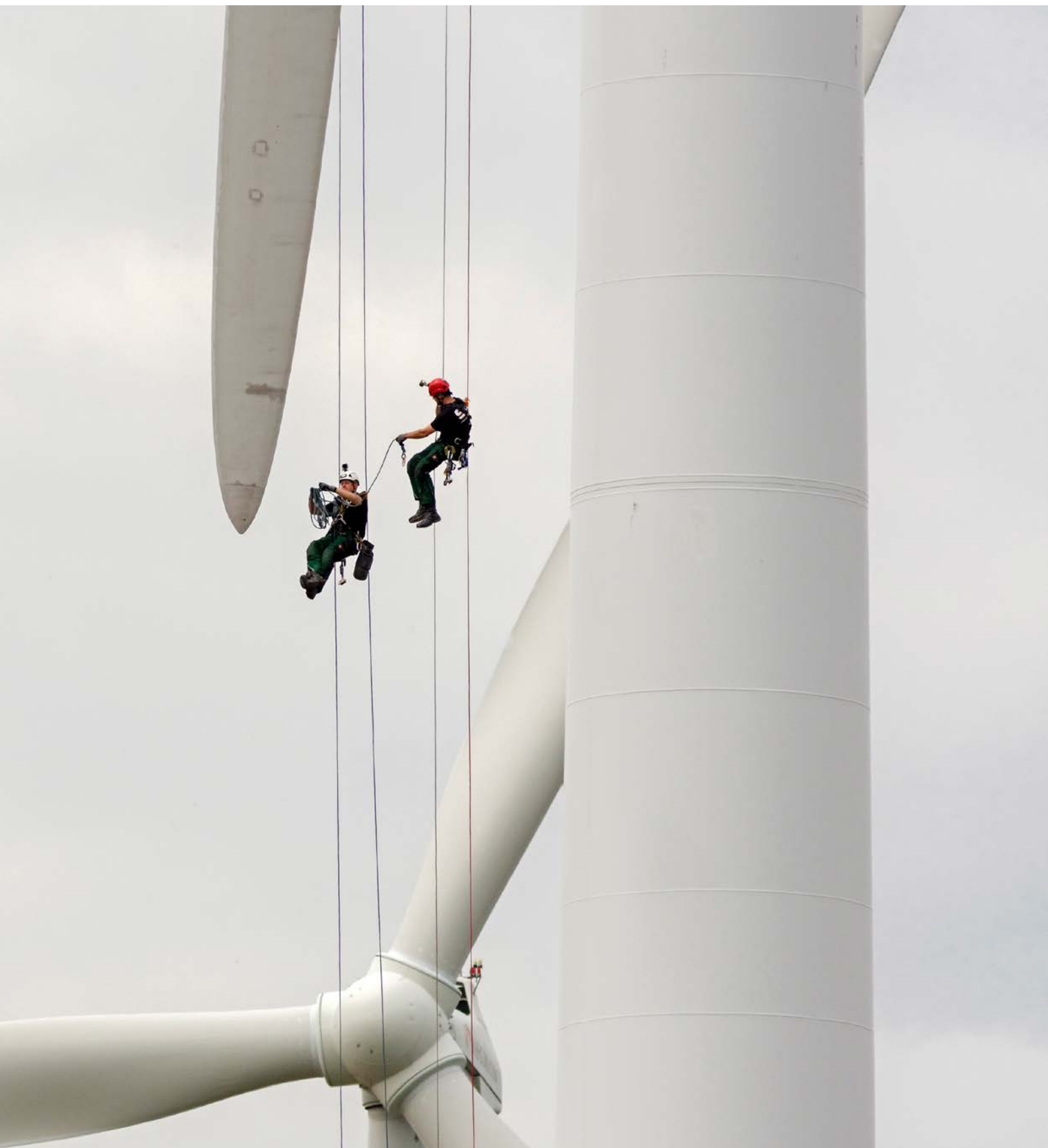
Industriekletterer prüfen Rotorblätter von Windkraftanlagen. Foto: Paul-Langrock.de
