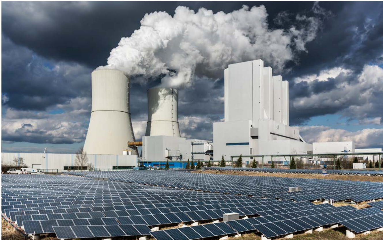
Braunkohlekraftwerk Lippendorf Böhlen, vorn Freiflächenphotovoltaikanlage. Foto: Paul-Langrock.de
