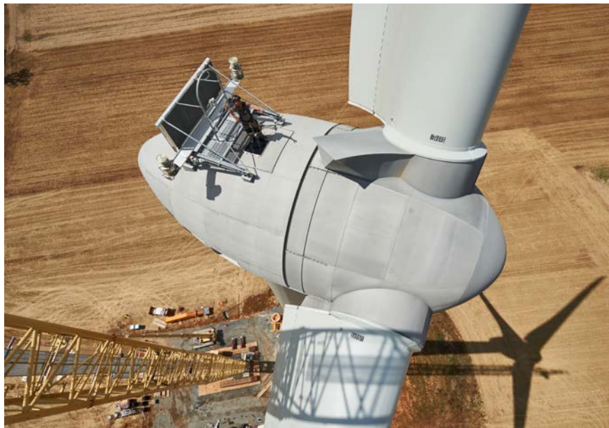
Aufbau einer Enercon E-101 im Windpark Melleran, Frankreich. Foto: Jan Oelker
