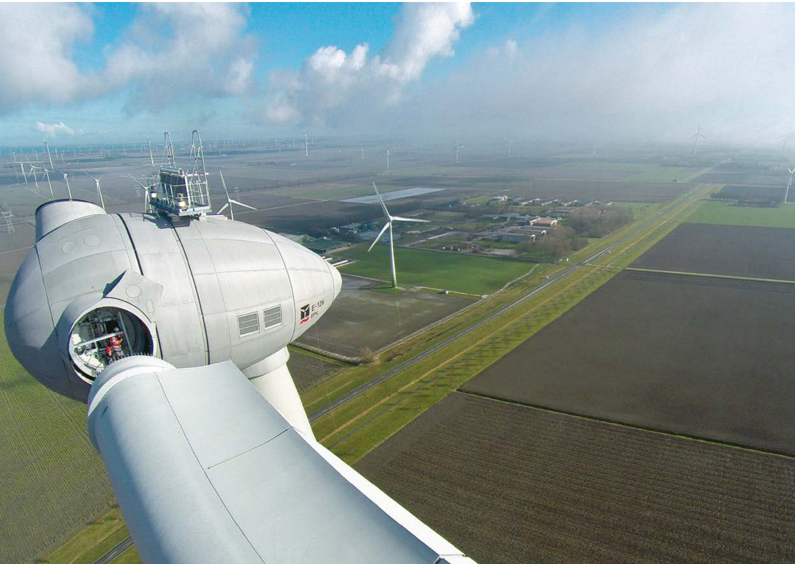
Enercon E-126 EP4-Prototyp in Lelystad in den Niederlanden. Foto: Klaas Eissens / ENERCON GmbH
