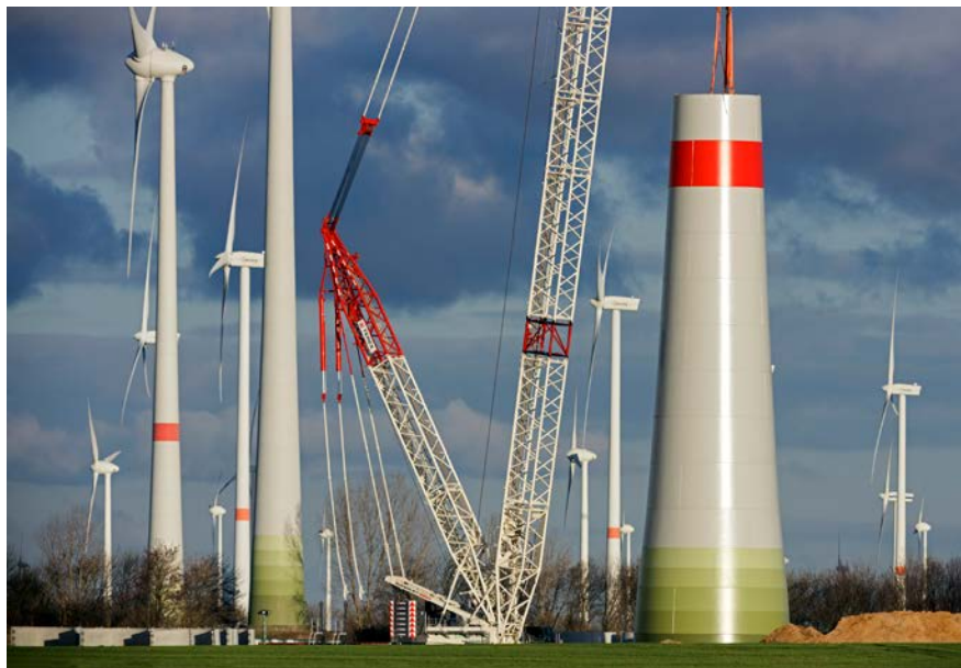
Aufbau Enercon E-115 im Windkraftpark Feldheim. Foto: Paul-Langrock.de
