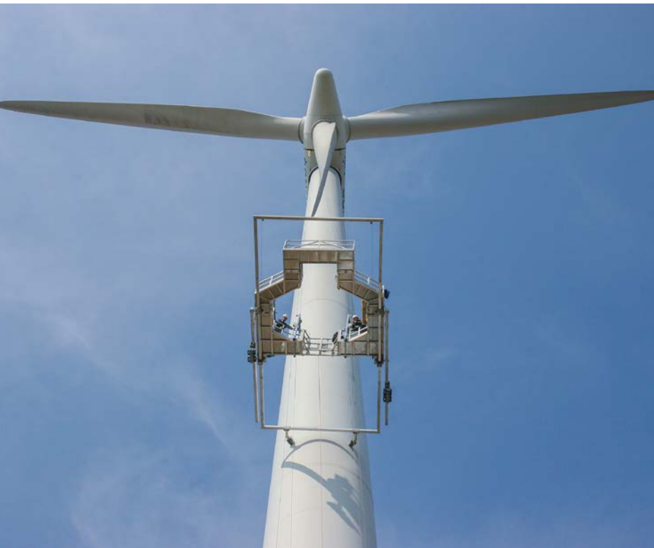
Arbeitsplattform für sicheren Zugang zu den Rotorblättern. Foto: Deutsche Windtechnik
