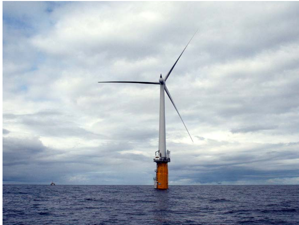
Schwimmende Windenergieanlage in Norwegen. Foto: Trude Refsahl - Statoil
