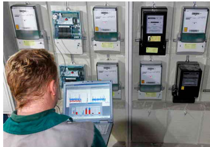
Stadtwerke Spremberg: Smart Metering Pilotprojekt. Foto: Rainer Weisflog
