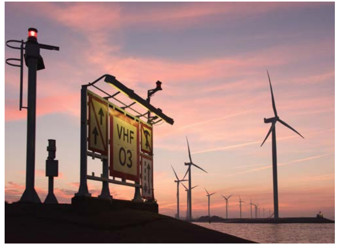
Windpark Delfzijl Noord, Niederlande. Foto: Ulrich Mertens
