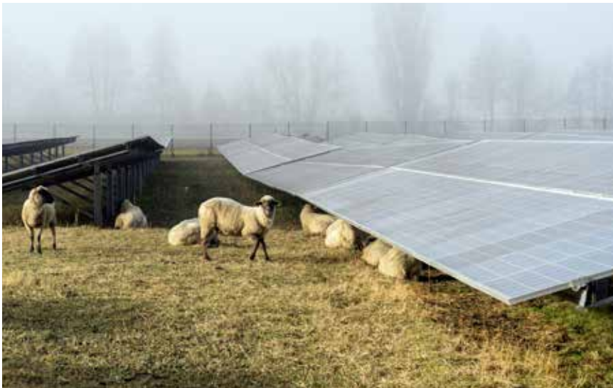
Bürgerenergiegenossenschaft Solarpark Vogtsburg. Die Energiegenossenschaft besitzt zu 75 Prozent diesen Solarpark mit 7,7 MW Spitzenleistung und 31.000 Solarmodulen, das restliche Viertel gehört der F S Solar Concept. In regelmäßigen Abständen Schafbeweidung. Foto: Paul Langrock
