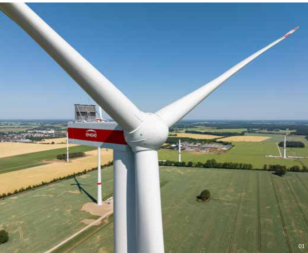
01 | Repowering-Windpark Karstädt (Brandenburg) 02 | Abbau Altanlagen Karstädt
