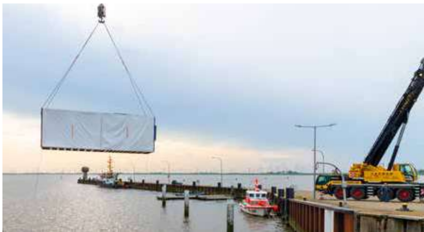
Umsetzung des Messcontainers Korrosionsschutz von BAM TTS zum Eidersperrwerk. Quelle: BAM
