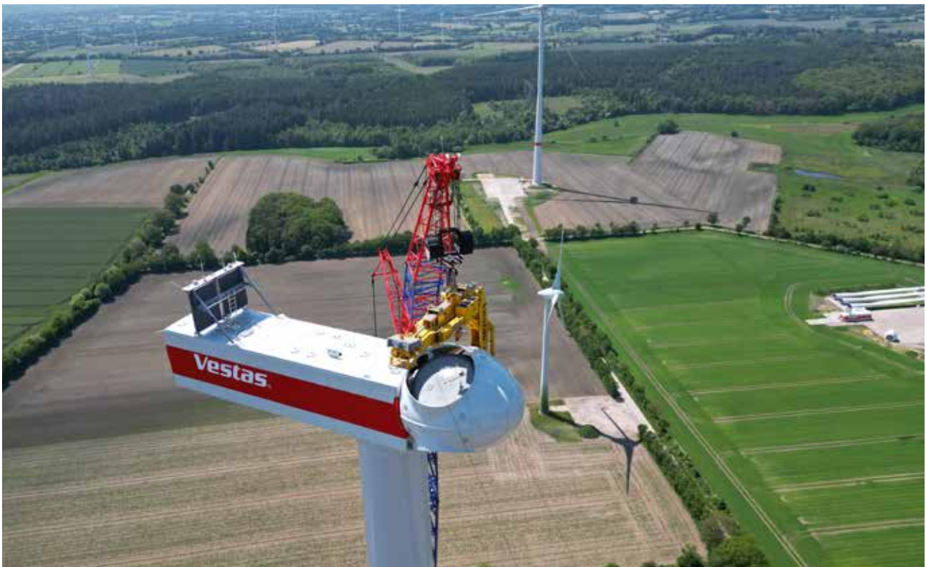
Installation der Nabe im Windpark Reher im Juni 2023 (Foto J.Weidkamp)
