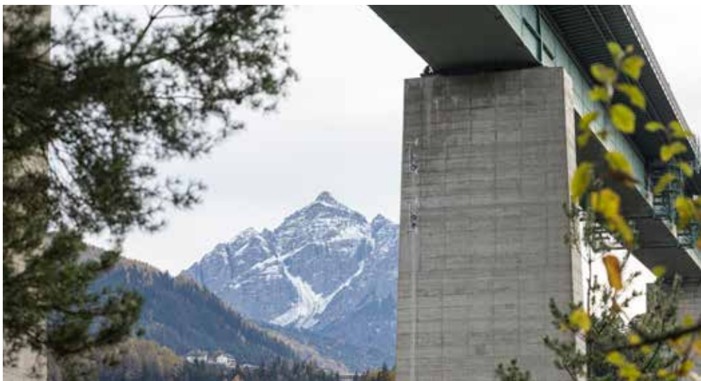
Blick auf die Europabrücke mit installierten MOWEA-Turbinen
