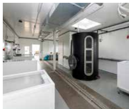
Der Messcontainer von innen. Quelle: BAM
