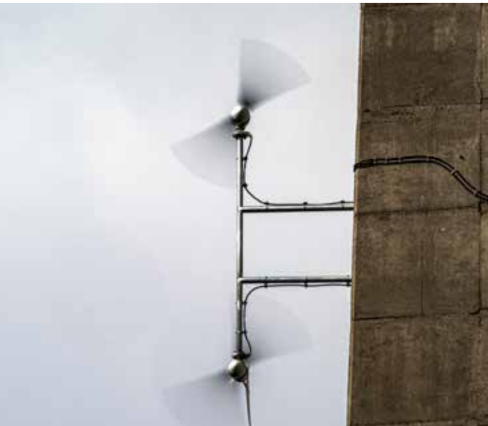
MOWEA-Windturbinen auf der Europabrücke
