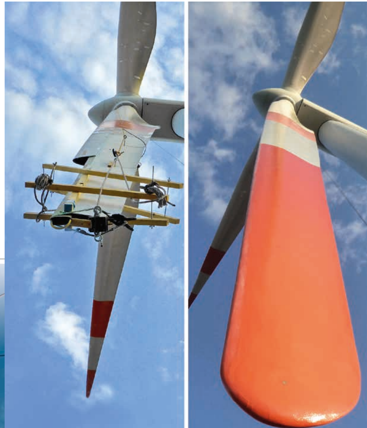
Abb. 1 : Wegen eines Blitzschadens waren die Blattschalen auf einer Länge von zehn Metern zerstört und mussten erneuert werden (links). Eine Reparatur des Blattes war mittels eines speziellen Verfahrens möglich, ohne es komplett zu demontieren (rechts)
